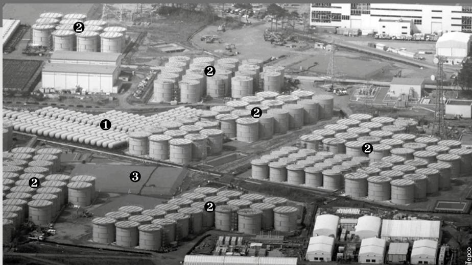
▲ **Les Shadok au Japon.** L'eau radioactive est stockée dans les citernes (qui font la taille d'un wagon) ①, dans les cuves de 1000 m<sup>3</sup> qui font cinq étages de haut ② et dans des réservoirs creusés dans le sol recouvert d'une bâche ③. Ces derniers ont été vidés après la découverte de fuites en avril 2013. Les cuves commencent à lâcher... et l'eau doit donc sans cesse être repompée pour être stockée ailleurs. 400 m<sup>3</sup> s'ajoute chaque jour.
