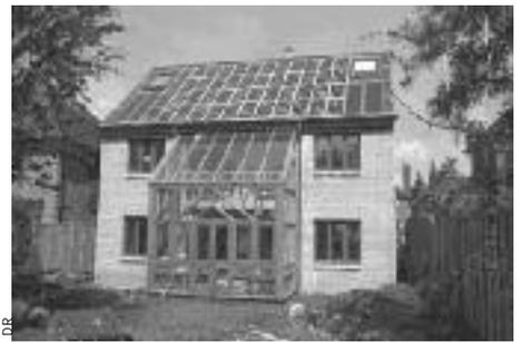
Photopiles + capteurs eau + serre solaire.
