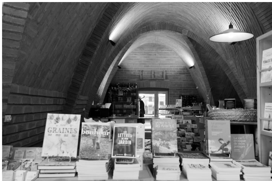
Ce bâtiment en briques de terre crue, avec voûte nubienne, abrite la librairie et le restaurant.
