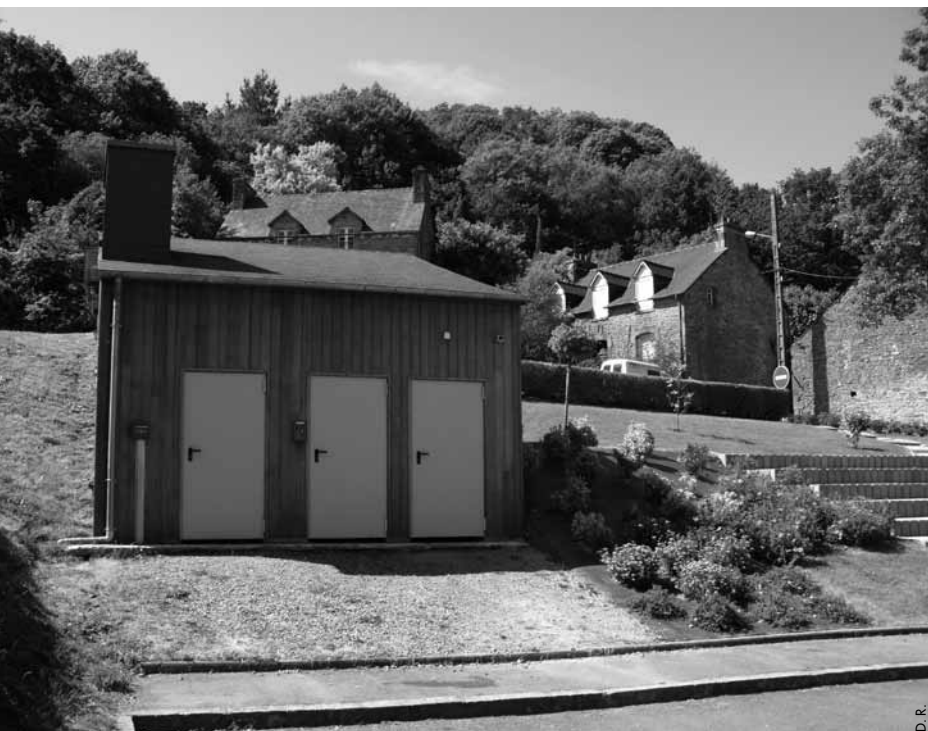
▲ Chaufferie bois de Saint-Gouéno.
