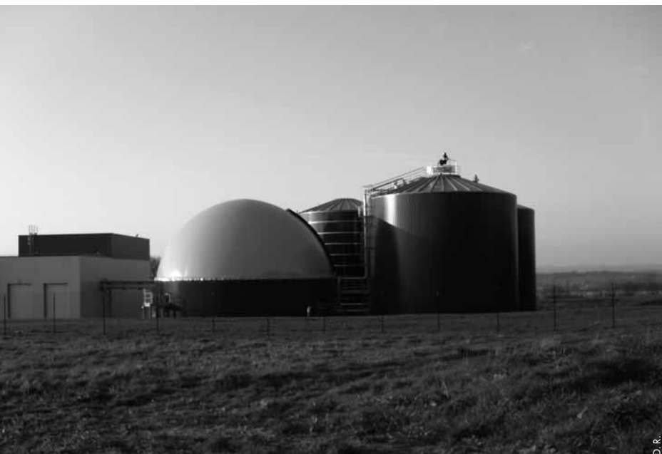
▲ Cuves digesteurs de l'usine de méthanisation Géotexia.
