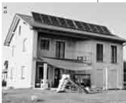
▲ Capteurs solaires thermiques... illégaux ?
