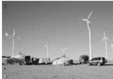
▲ alors que l'Occident mise sur le gigantisme, la Chine et l'Inde développent surtout des installations de petites tailles, ici des éoliennes de 20 kW
