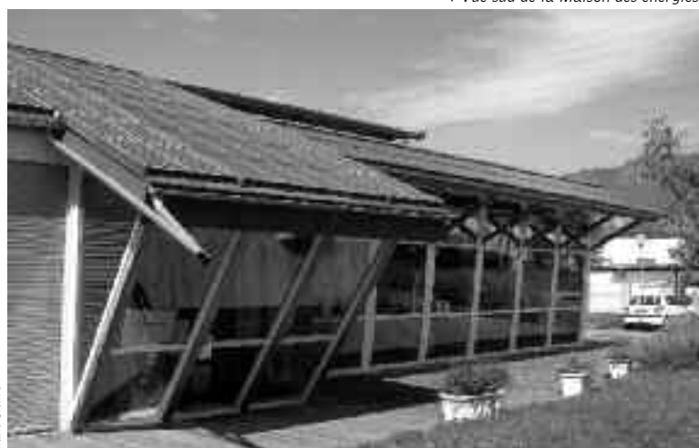
▼ Vue sud de la Maison des énergies
