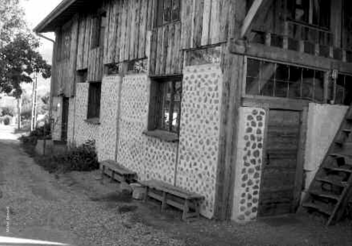
Bâtiment abritant la fromagerie, la boulangerie et le groupement Couleurs Saisons
