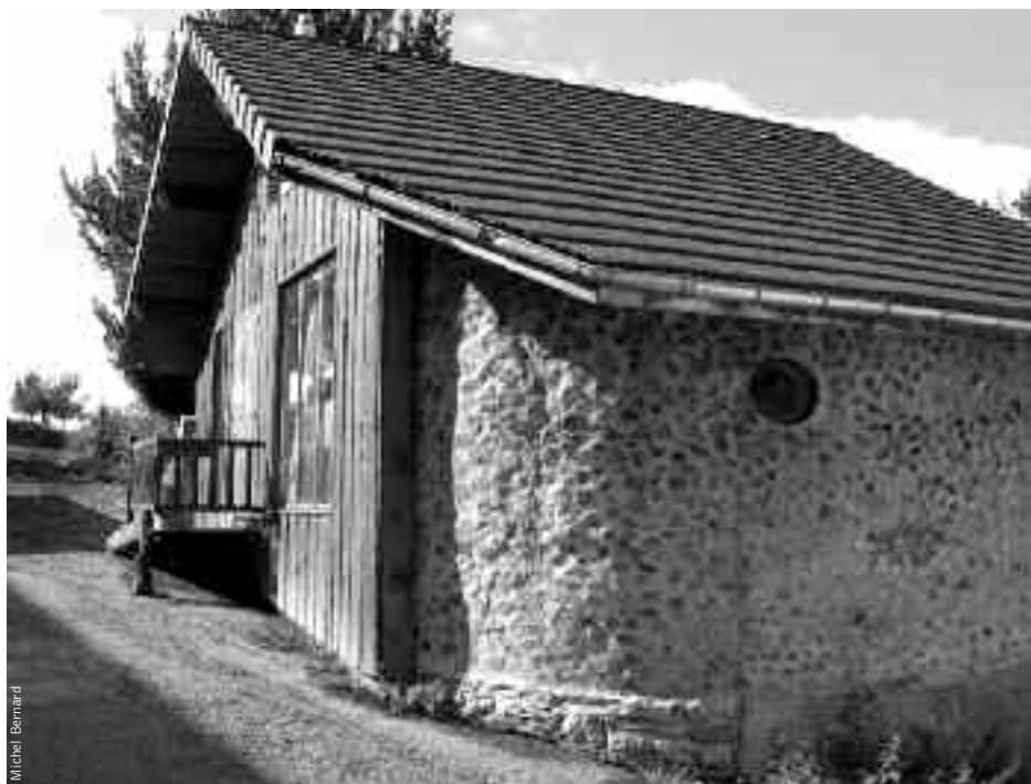
L'école construite en bois cordé
