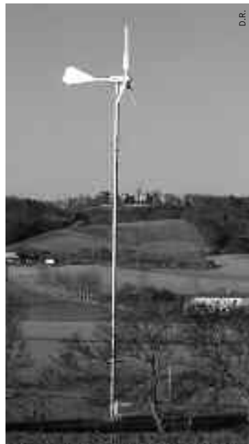
Éolienne individuelle d'un coopérateur.
