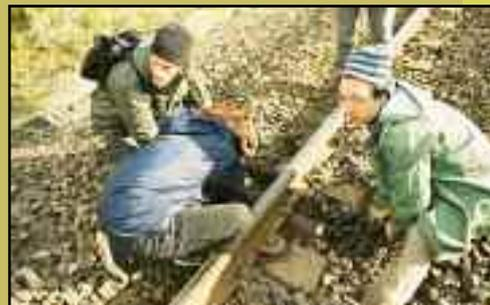
**Déterrage d'un tuyau résistant, installé sous un rail bien au préalable.**
