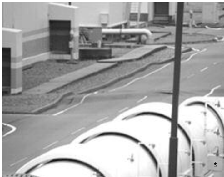
Le sol de la centrale plissé par le séisme.
