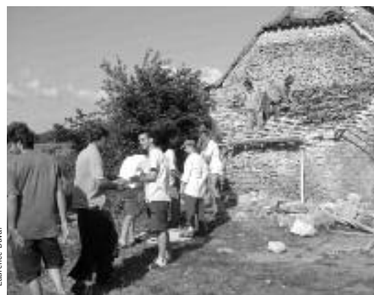
Réfection d'un four à pain..
