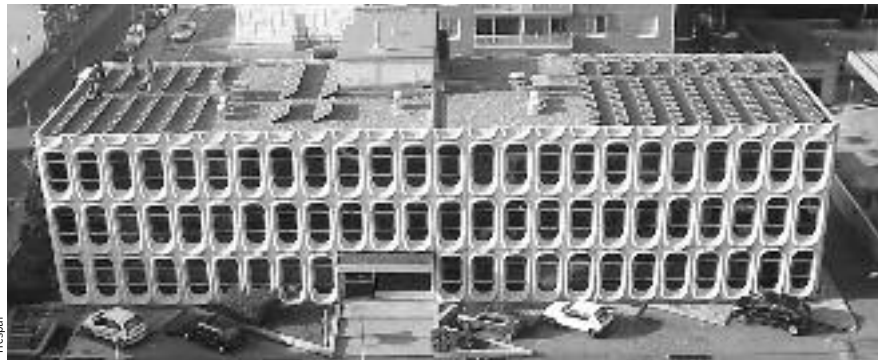
Toit solaire installé par Hespul à Villeurbanne (immeuble abritant les locaux d'Hespul et de La Nef).
