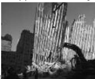
DR Un chantier dangereux.
