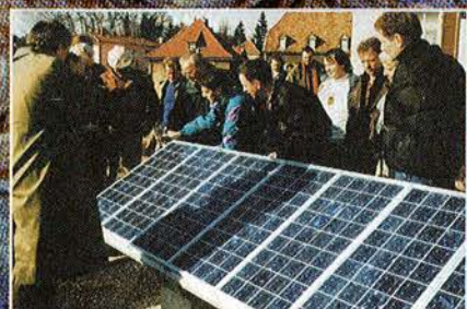
Installation d'une centrale solaire
