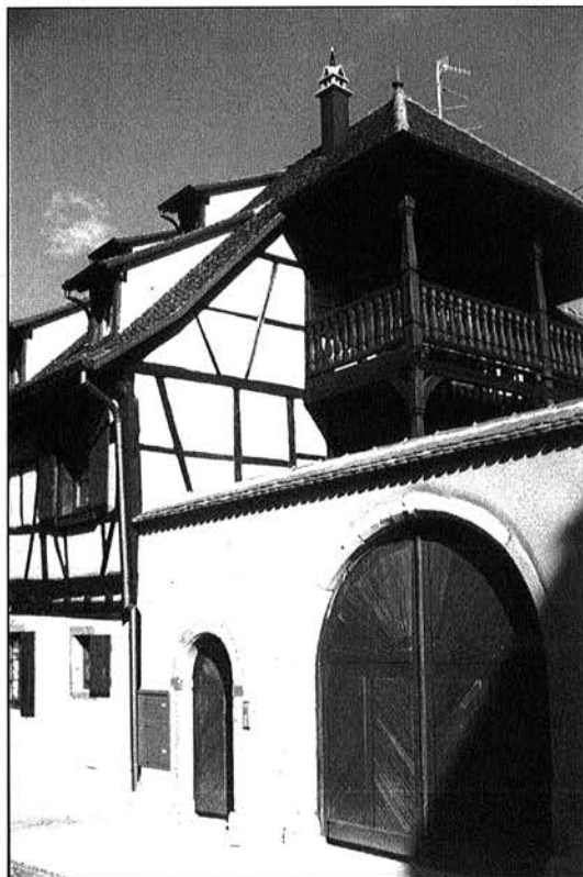
Maison à Dambach-la-ville à armature et crépis écologiques
