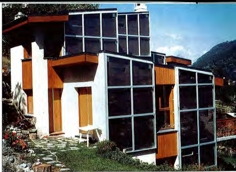
Immeuble chauffé à 70 % par l'énergie solaire à Briançon / Photo © R. Bernard
