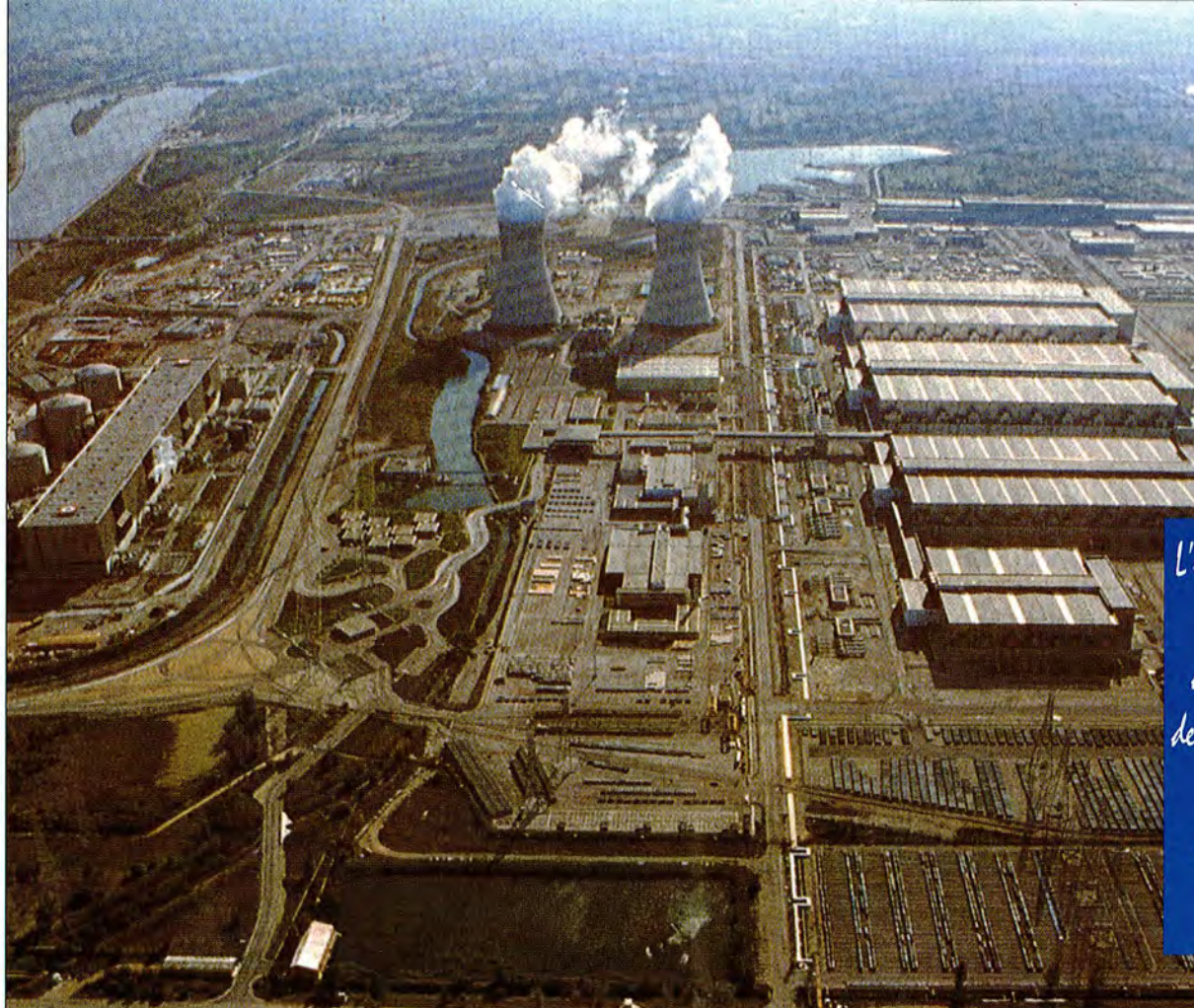
Vue de l'usine Eurodif
