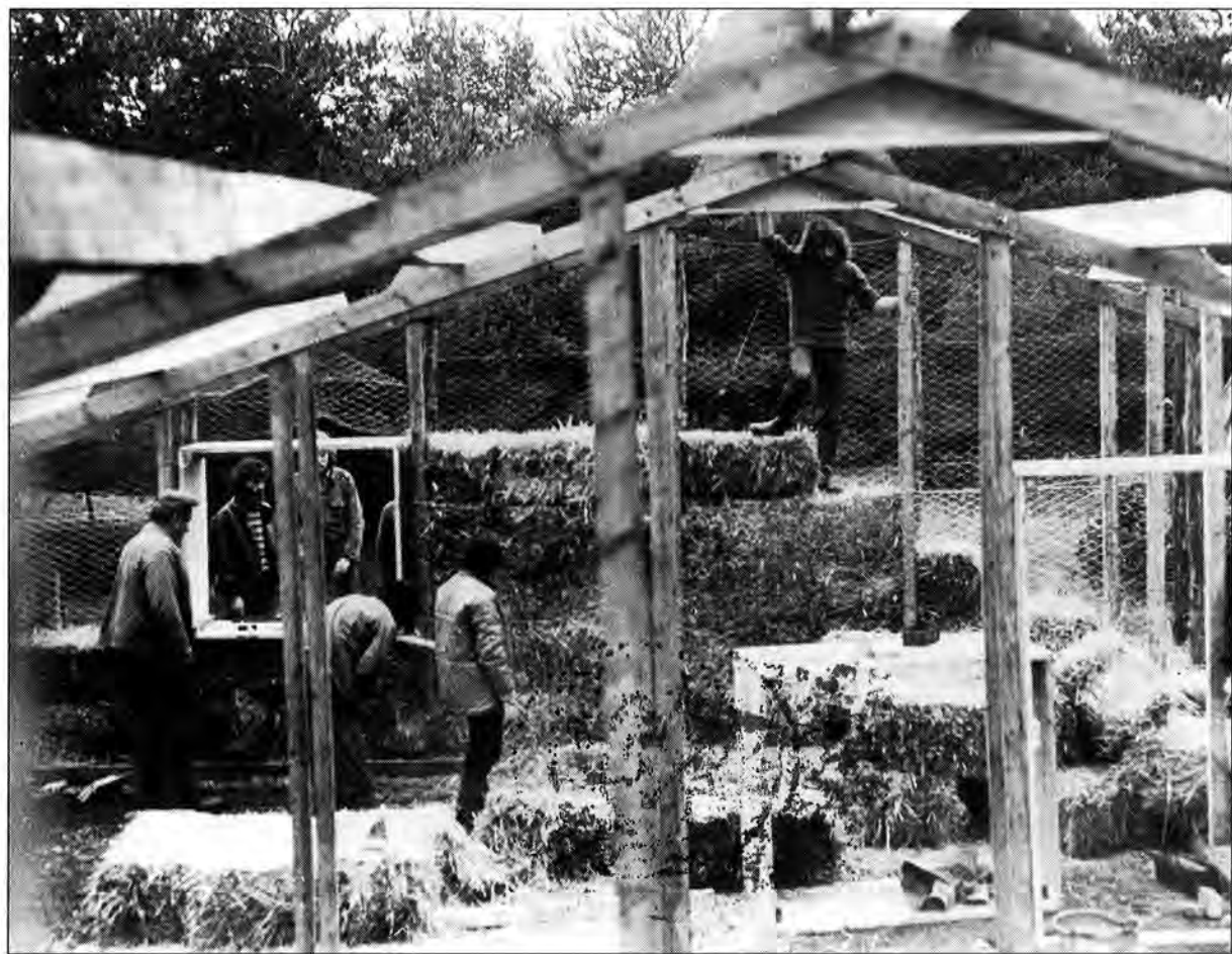
Octobre 1979 : construction du premier bâtiment du Cun en bottes de paille (photo Cun)
