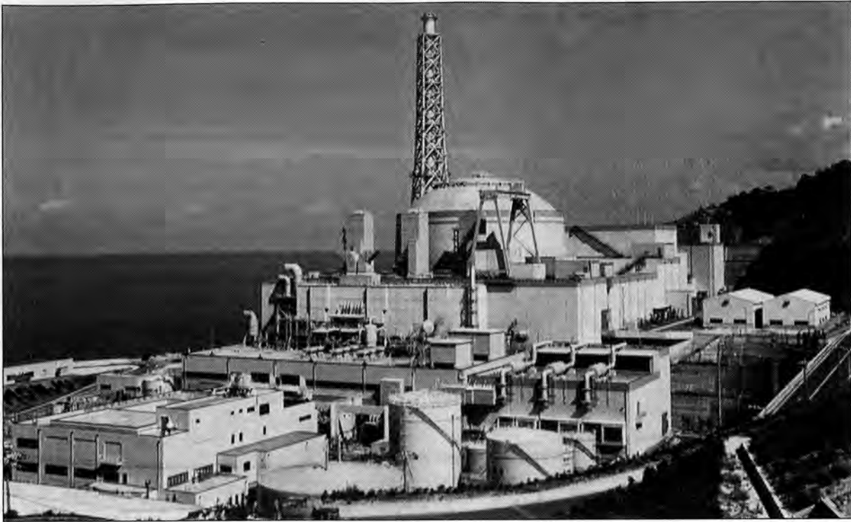
Le surgénérateur de Monju : le petit frère de Superphénix justifie en partie le stockage de plutonium par le Japon... mais les intérêts militaires ne sont pas loin ! (photo AIEA)
