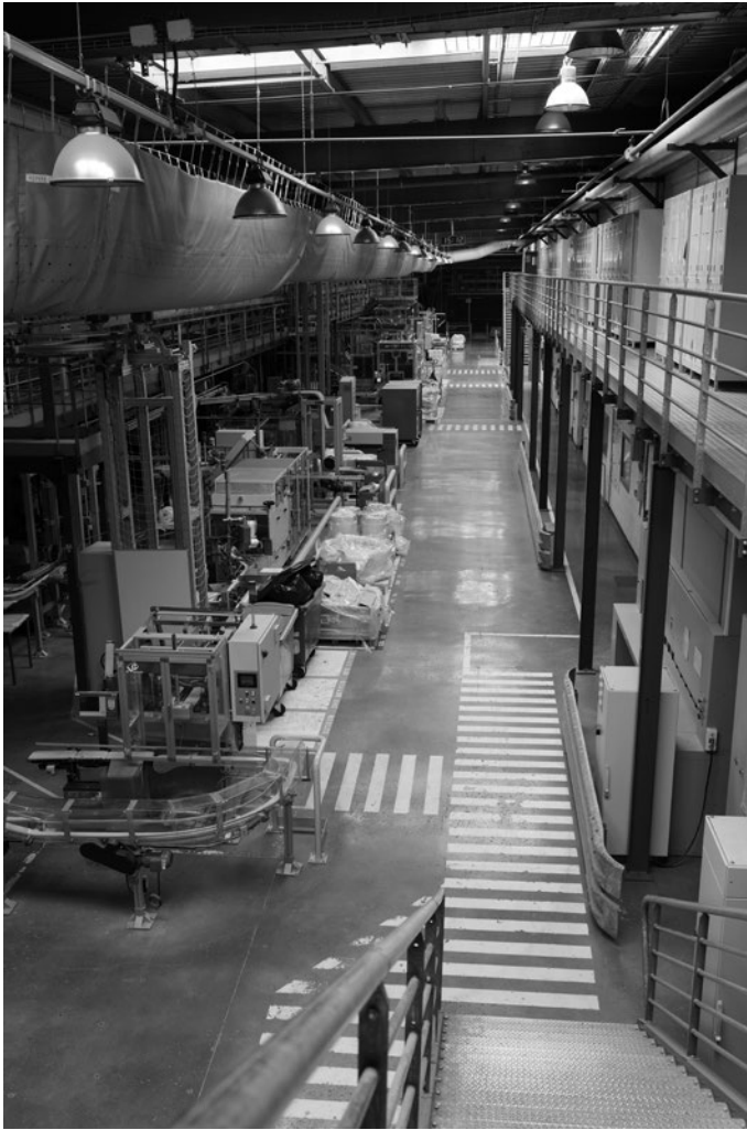
L'un des hangars où se trouvent les machines outils.
