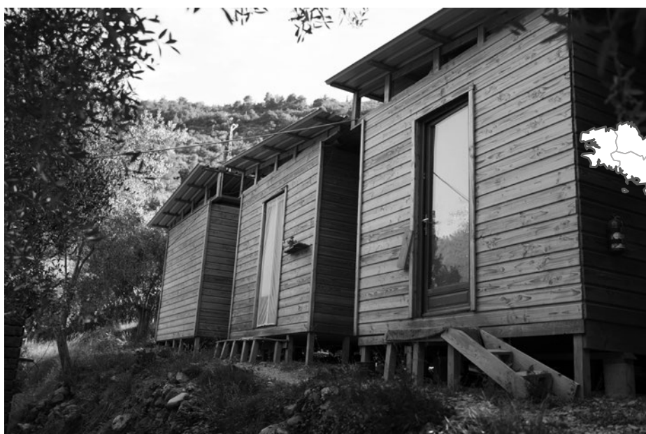
Cabanons construits en 2018. Au départ, chacun est un dortoir qui peut accueillir 4 personnes. Depuis, ils ont été transformés en logements individuels.
