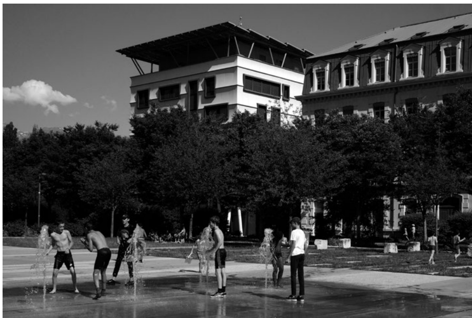
À la gauche d'un ancien bâtiment de la caserne, aujourd'hui rénové en logements sociaux, un petit immeuble de bureaux à énergie positive. Le toit est une installation photovoltaïque.
