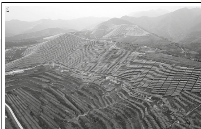
Chaque panneau visible comprend 24 modules et fait environ 20 m 2
