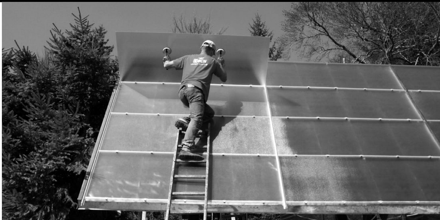
▲ Mise en place des vitres lors d'un chantier d'autoconstruction.
