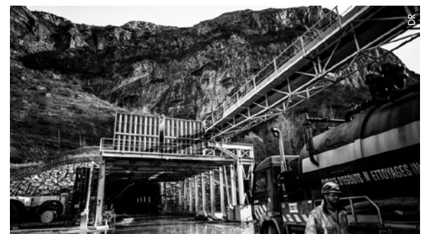
Les travaux de construction de la ligne à grande vitesse à Saint-Martin-la-Porte en novembre 2018.
