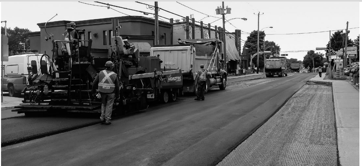
▲ Travaux de bitumisation à Victoriaville, au Québec.
