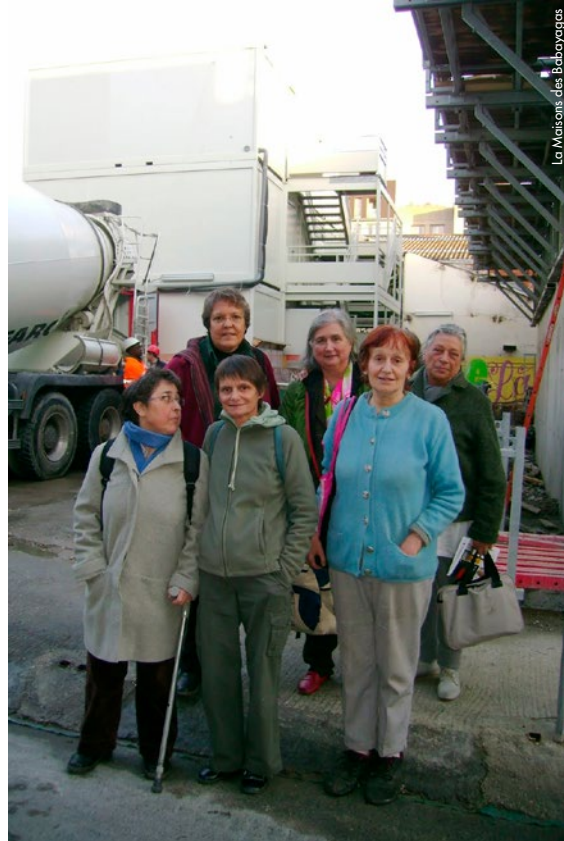
Quelques Babayagas sur le chantier de leur future maison collective, à Montreuil, en 2012.
