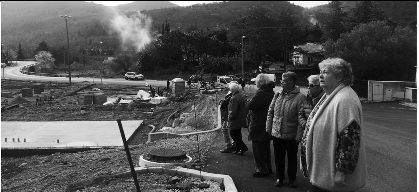
▲ Des membres des Coquelicots devant les fondations de leurs maisons. Les Coquelicots, à Soubes (Hérault), est un habitat participatif pour seniors solidaires, avec la construction de 12 petites maisons adaptées au vieillissement. "Ouvert sur le village, ouvert à la vie associative".
