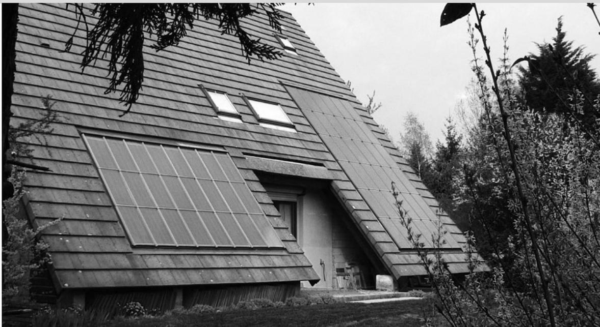
▲ Panneaux photovoltaïque et thermique intégrés dans une toiture.
