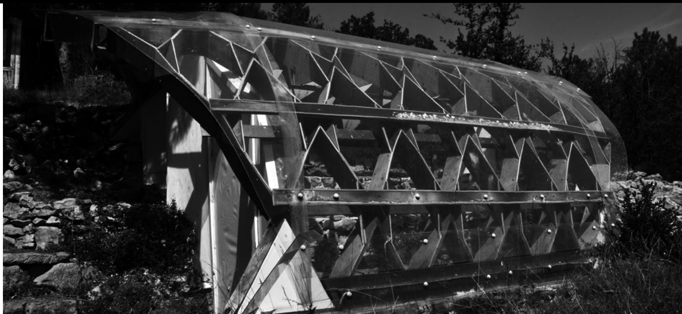
▲ La serre expérimentale est entièrement réalisée à partir de cartons pliés et de plexiglas. Elle a été réalisée par une association d'étudiant-es de l'école d'architecture de Montpellier.
