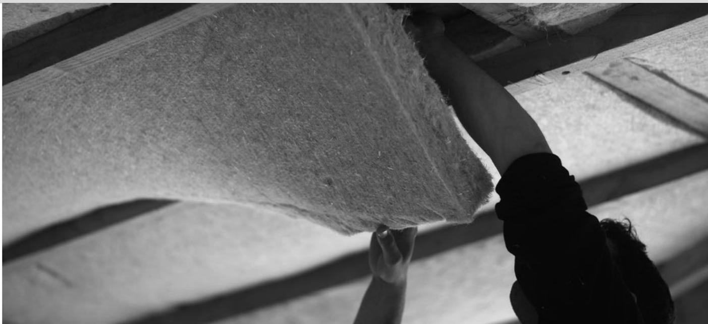
▲ Pose de panneaux d'isolant en fibre de chanvre
