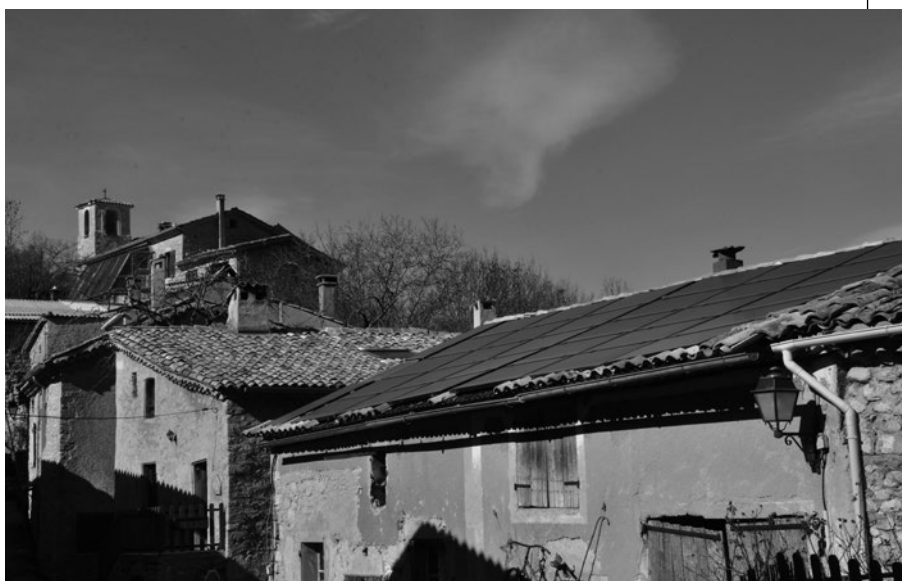
Toiture photovoltaïque sur un des bâtiments du village
