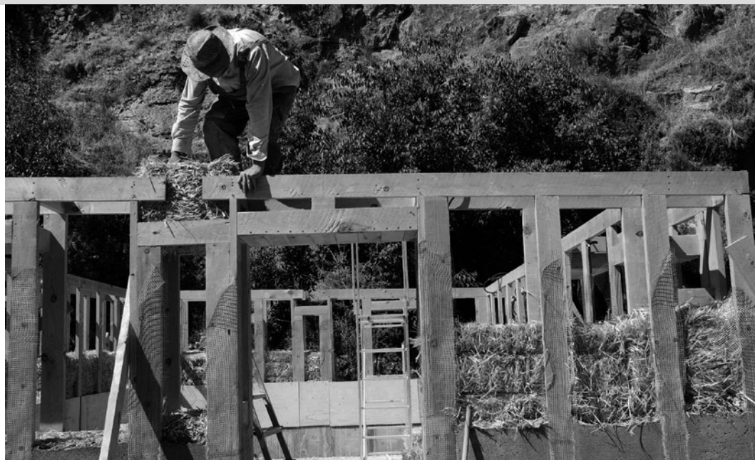
▲ Autoconstruction de la maison en bois et paille
