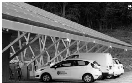
Voitures communales électriques, sous un toit photovoltaïque
