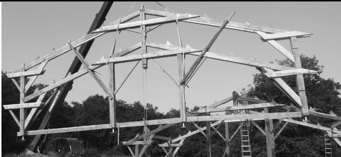
▲ La technicité de montage demande beaucoup de précision et apporte aussi la satisfaction du bel ouvrage : hangar agricole en ossature bois
