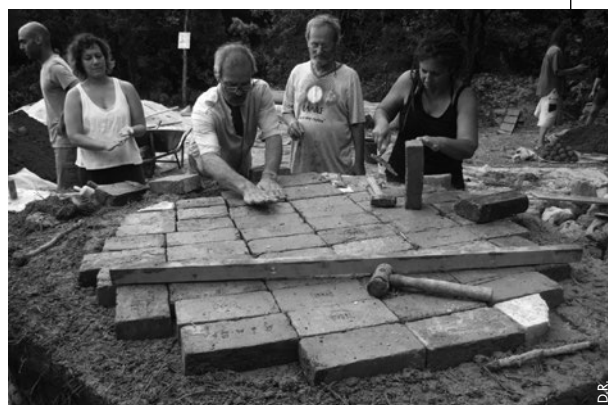
Chantier participatif : construction d'un four à pain (la sole)
