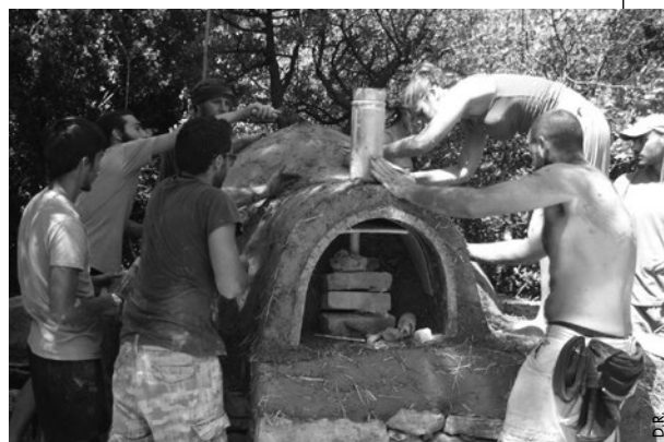
Chantier participatif : construction d'un four à pain (la voute)
