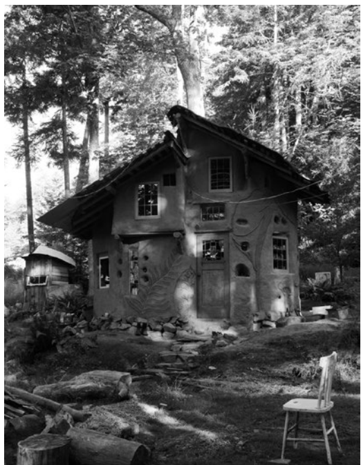
▲ Maison construite par les Mudgirls en juillet 2011
