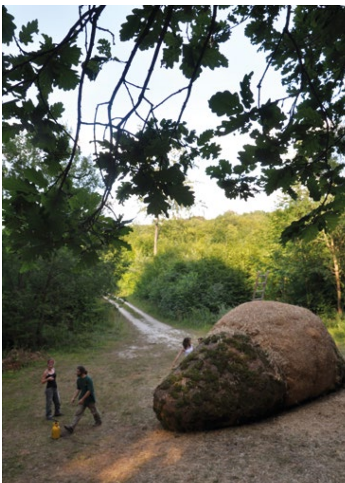
▲ Srinivasa Prasad, indien, a réalisé une cabane en torchis (paille, terre et bouse de vache, donc 100 % de récupération).
