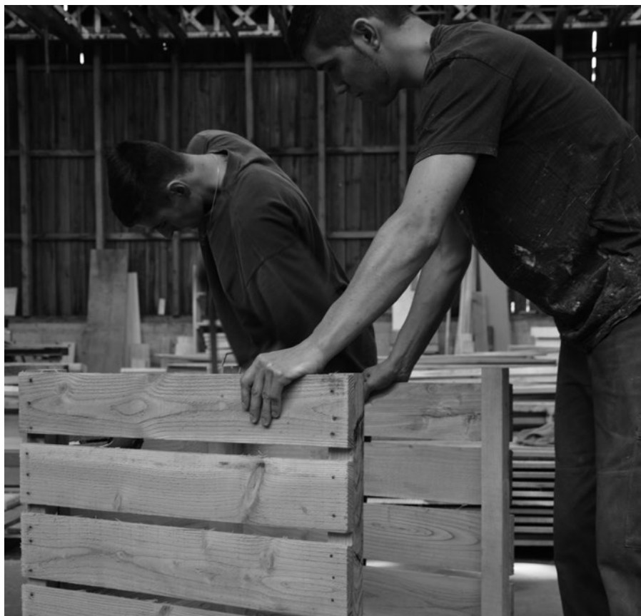
▲ Construction d'un composteur
