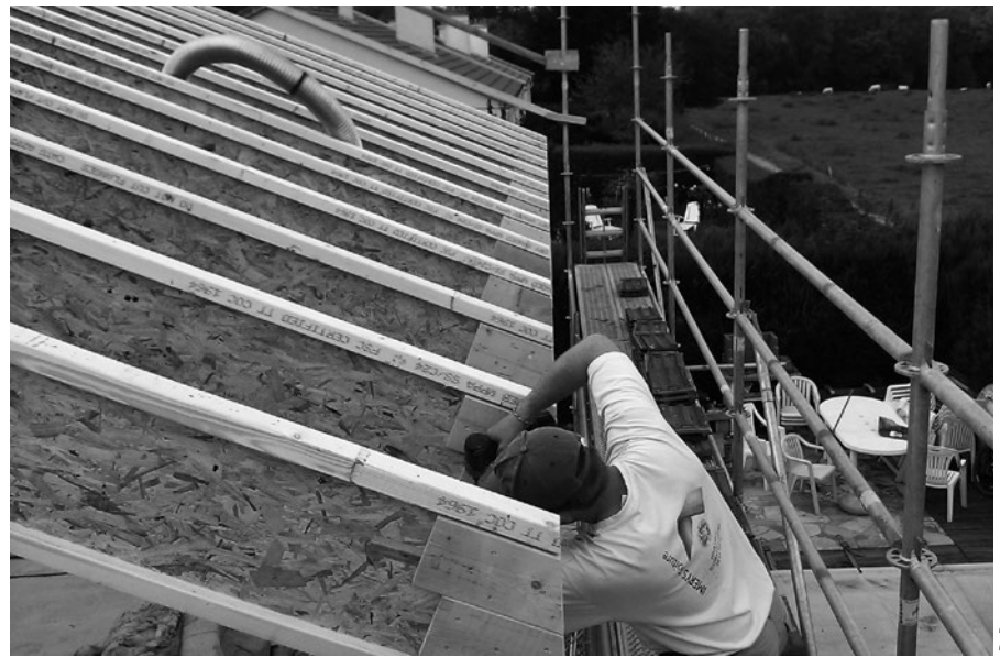
▲ Isolation de la charpente.
