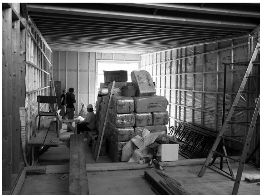
▲ La salle multi-activités en chantier... (été 2011).
