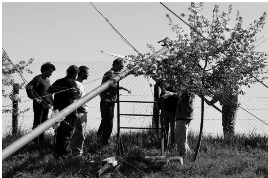
▲ Stage d'entretien de l'éolienne avec l'association Tripalium.
