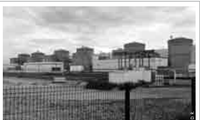
▲ Centrale de Gravelines (Pas-de-Calais)
