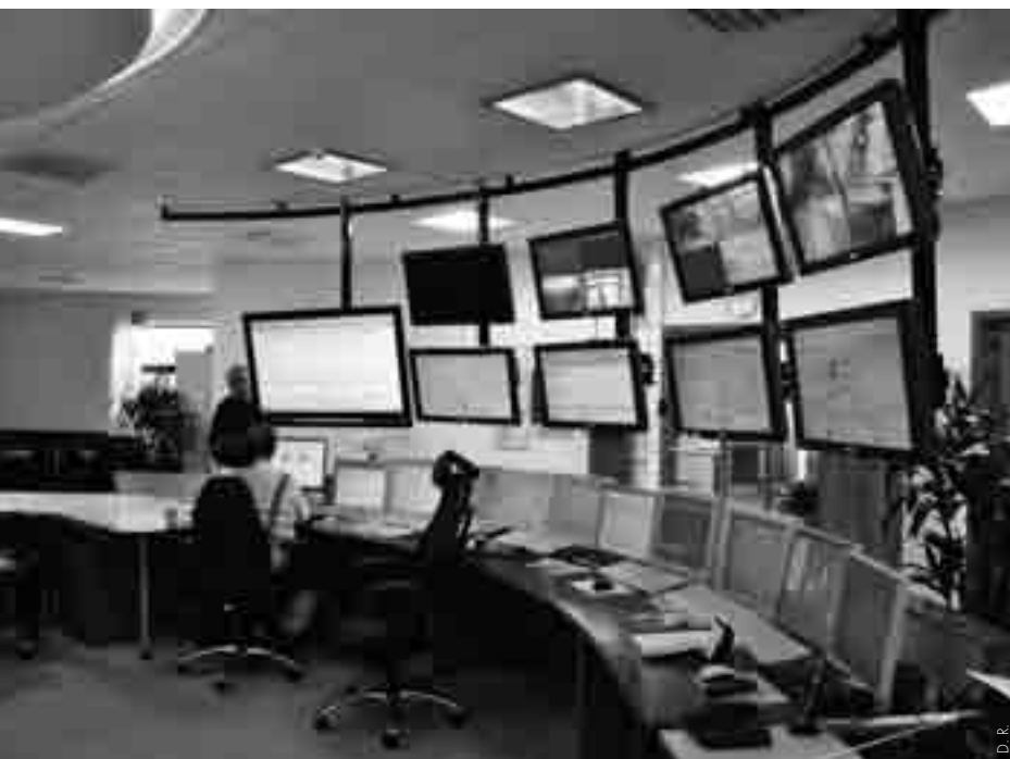
▲ Salle de contrôle de l'incinérateur de Trondheim, Norvège. Fournit de la chaleur au réseau de chauffage urbain. Dans plusieurs pays, l'incinération de déchets est considérée comme une source d'énergie renouvelable. C'est pourtant très polluant.
