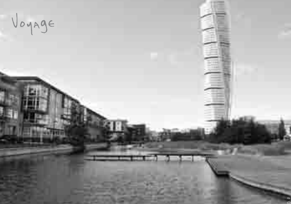
▲ Ecoquartier de Malmö, Suède. Reconversion d'une exposition universelle avec la curieuse tour qui se présente comme "durable".
