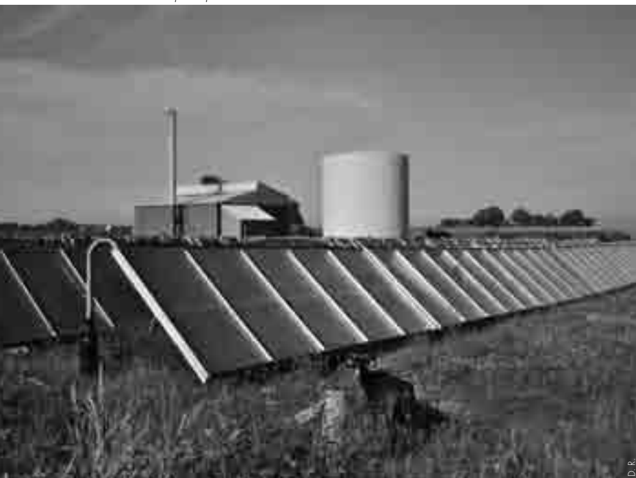
▲ Système de chauffage solaire communal, Samsø, Danemark.
