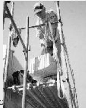
Construction en brique alvéolée.
