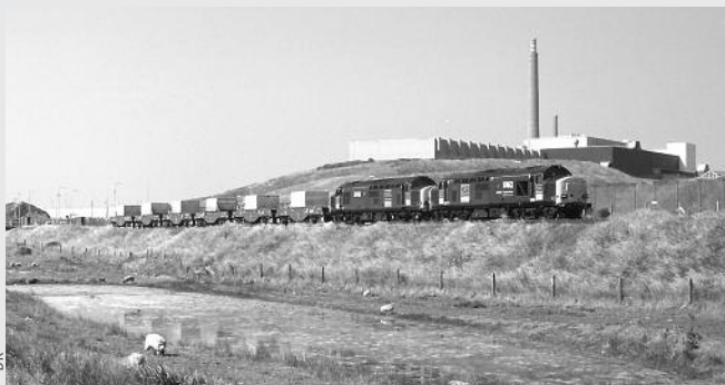
L'usine de retraitement de Sellafield (GB).
