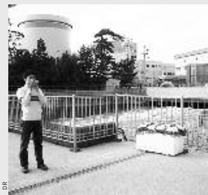
Centrale de Mihama.
