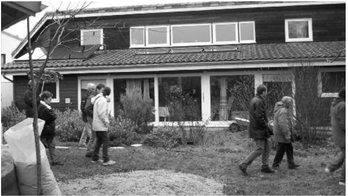
Maison d'Alain : ossature bois, serre et capteurs sur le toit.
