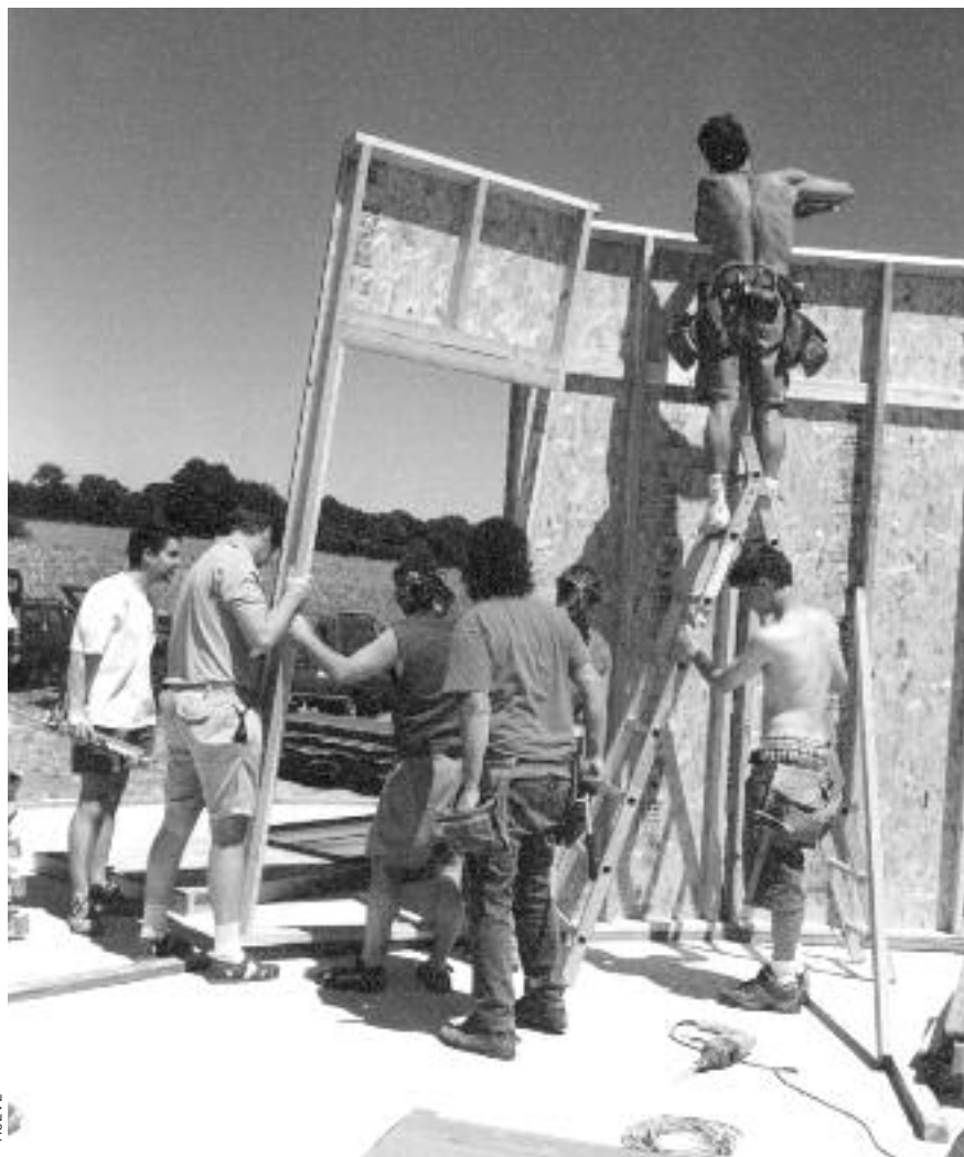
Construction de la yourte
