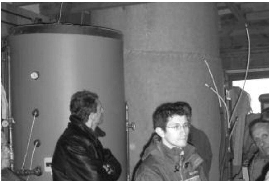
Maison Reinhold : les énormes réservoirs d'eau chaude.
