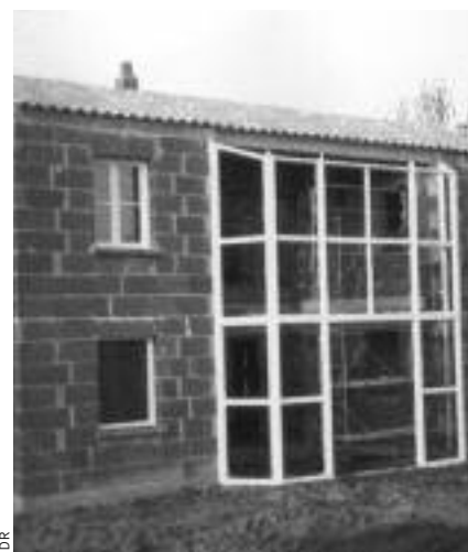
La serre en construction.
