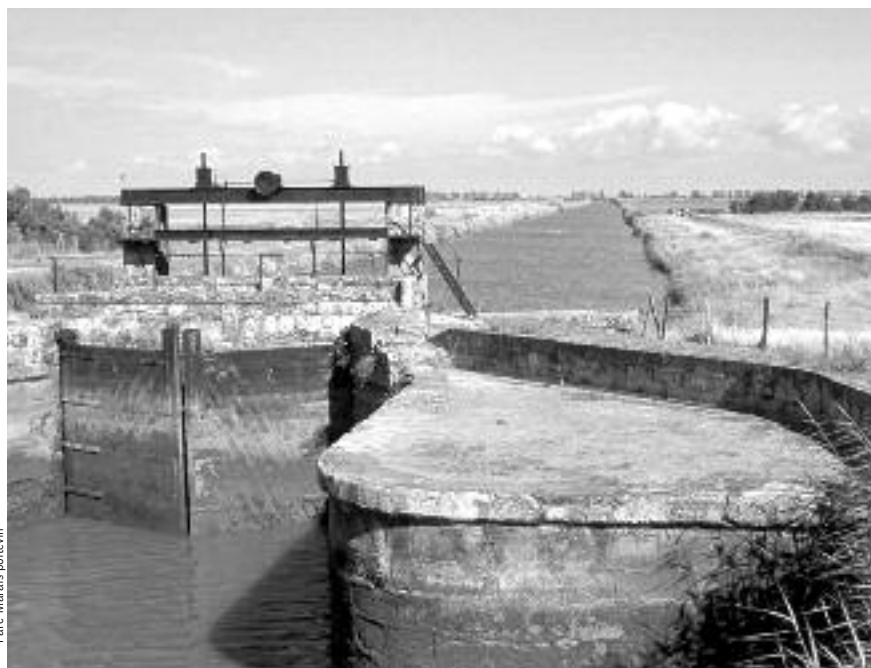
Ecluse entre le marais et l'eau salée de la mer.
