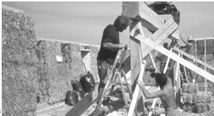
Construction d'une charpente pour maison en paille.
