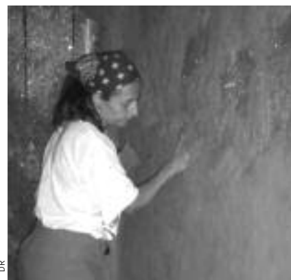
Coralie en train de passer un enduit sur un mur en paille.
