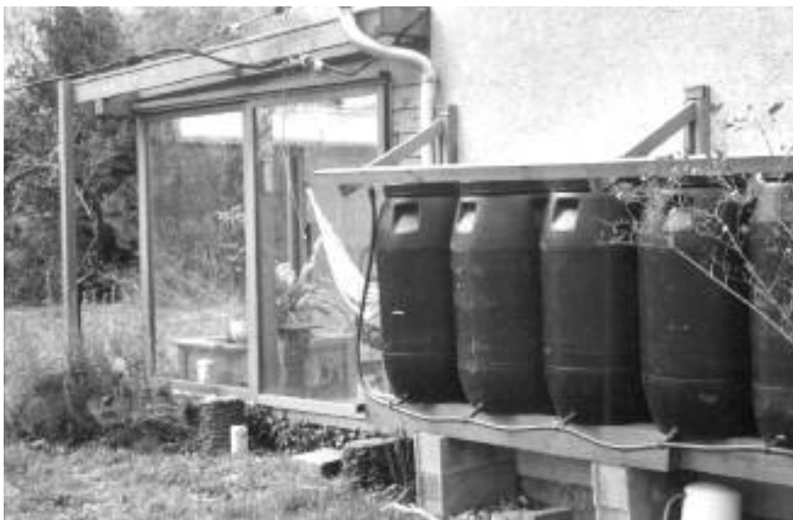
Maison de Gérard Nallet : serre et récupération des eaux de pluies.
