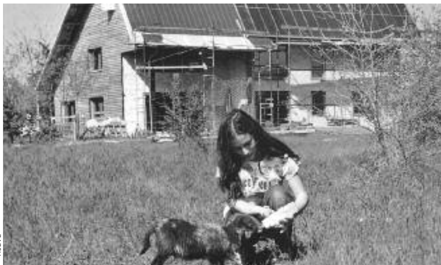
Maison de Reinhold et Brigitte : toit solaire eau chaude + électricité.
