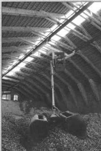
Photo REW Réserve de chaufferie au bois
