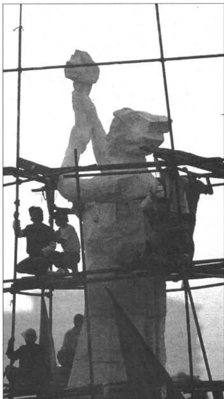
Construction d'une statue de la liberté Place Tien - an - Men - Chine - Mai 1989
