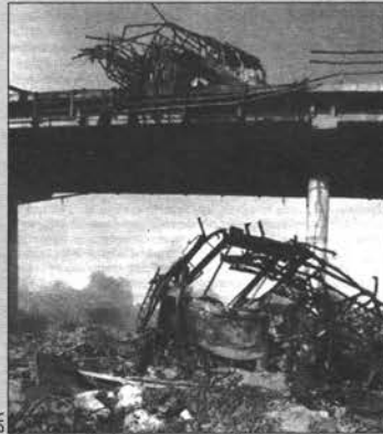
Bus bombardé sur un pont de Belgrade
